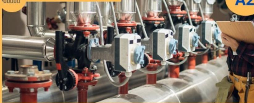
Da Pumpen eine lange Lebensdauer haben, sind in vielen Betrieben noch alte, unregelmäßige Pumpen zu finden. Eine fachgerechte und an das System angepasste Umrüstung auf Hocheffizienzpumpen kann den Stromverbrauch der Heizpumpen enorm reduzieren.
